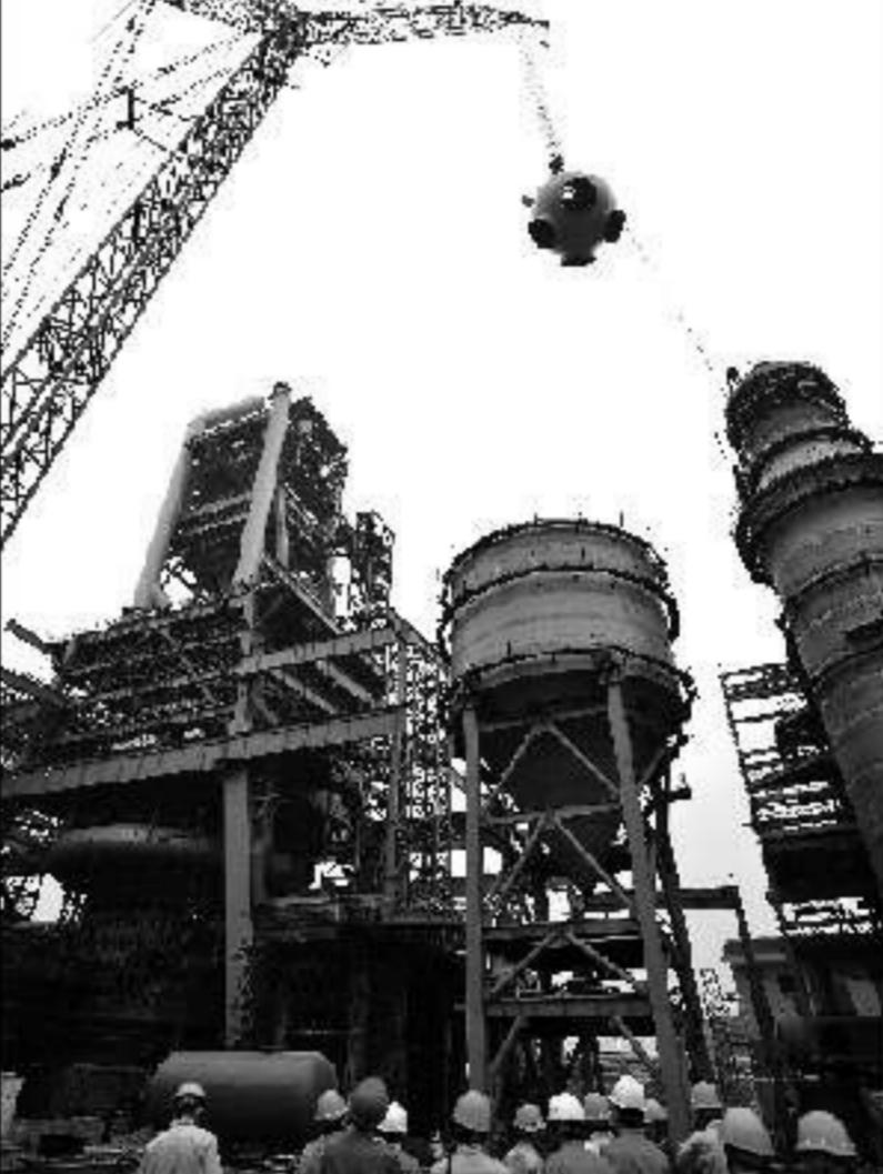
近日,宝钢集团梅钢公司5号高炉五通道成功吊装就位,标志着高炉粗煤气系统构架的形成。5号高炉建设是梅钢淘汰老旧装备、提升企业装备技术水平的二期建设的重点工程之一。新高炉环保和节能减排等一系列工艺技术的运用,将使梅钢的清洁生产水平再上新的高度。因为高炉五通道成功吊装场景。(秦峰宁 约通社记者朱飞 摄)
